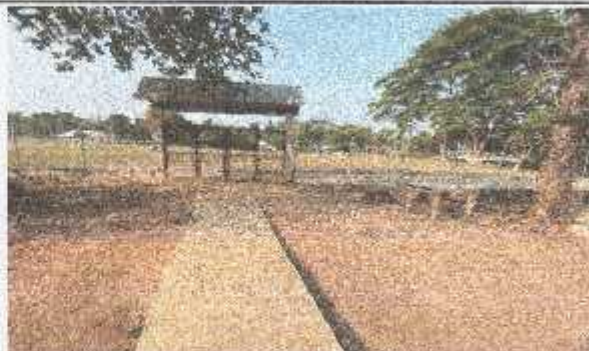
Foto 2: Se observa el cerco perimetral por el lado de adentro terminado.
