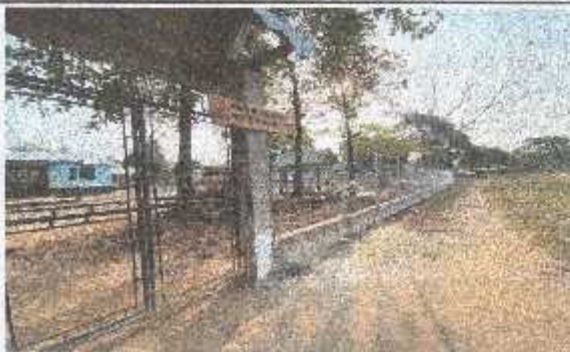
Foto 3: Se puede observar el cerco perimetral por el lado de afuera terminado.
