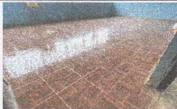
Foto 1: Se puede observar el piso del aula que quedó en buen estado.
