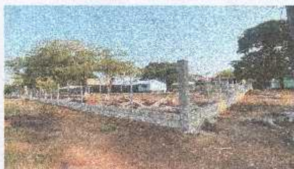
Foto 4: Se observa la esquina del área perimetral y el cerco está completamente terminado.
